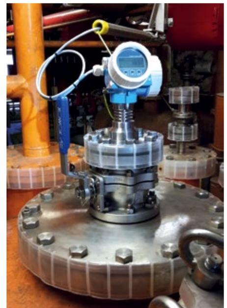
Abb. 2: Füllstandüberwachung mit Radar: Micropilot FMR52 im Prozessbehälter bei WeylChem in Wiesbaden.
