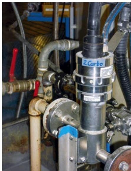
Abb. 2: pH-Messstelle bei der Zuckerproduktion
