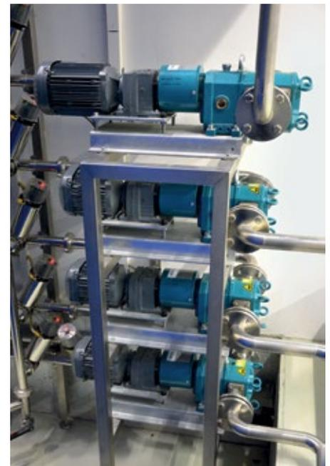
**Abb. 2:** Aufgrund der kompakten Bauweise der Drehkolbenpumpen konnten bei Jemako vier Pumpen sehr platzsparend übereinander installiert werden.
