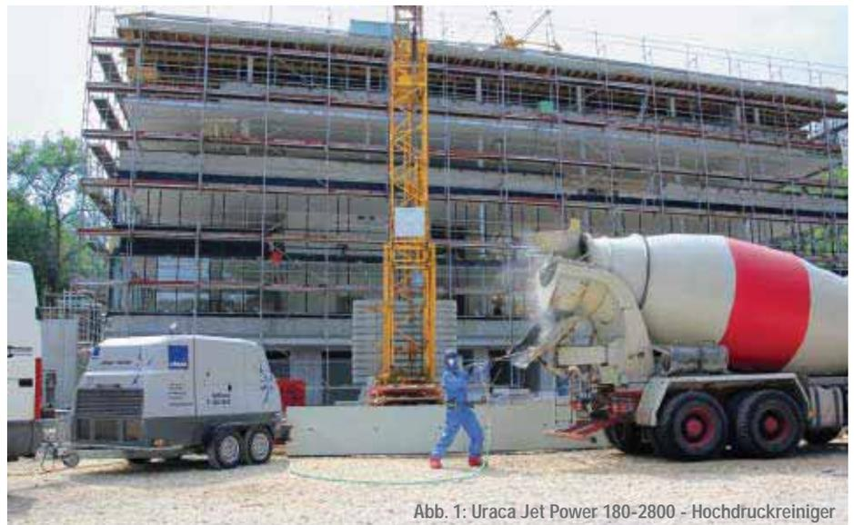
Abb. 1: Uraca Jet Power 180-2800 - Hochdruckreiniger
