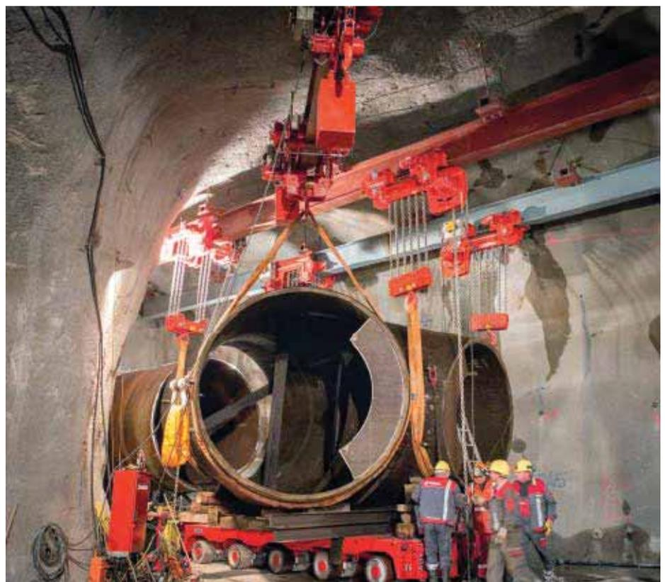
Abb. 1: Bis zu einer Wanddicke von 140 mm bestehen Abzweiger und Rohrsegmente aus Hochleistungswerkstoffen. Bei rund 4,5 m Durchmesser beträgt das Toleranzfeld lediglich 2 mm! ►
