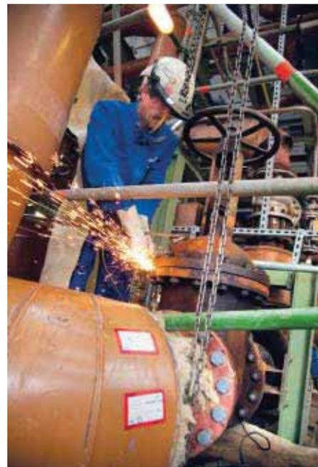
Abb. 2: Servicemitarbeiter von KSB beim Entfernen der korrodierten Schrauben an einem Hochdruckschieber.
