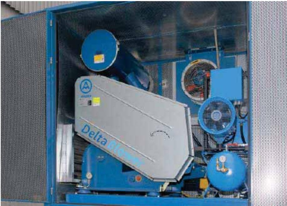
Abb.2 : Einsatz einer Emde-Staubsauganlage mit aufgebautem Aerzen Drehkolbengebläse (rechts im schalldämmenden Gehäuse) in einer Werkshalle.
