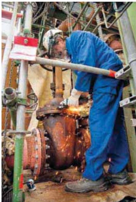
Abb. 1: Servicemitarbeiter von KSB beim Entfernen der korrodierten Schrauben an einem Hochdruckschieber.
