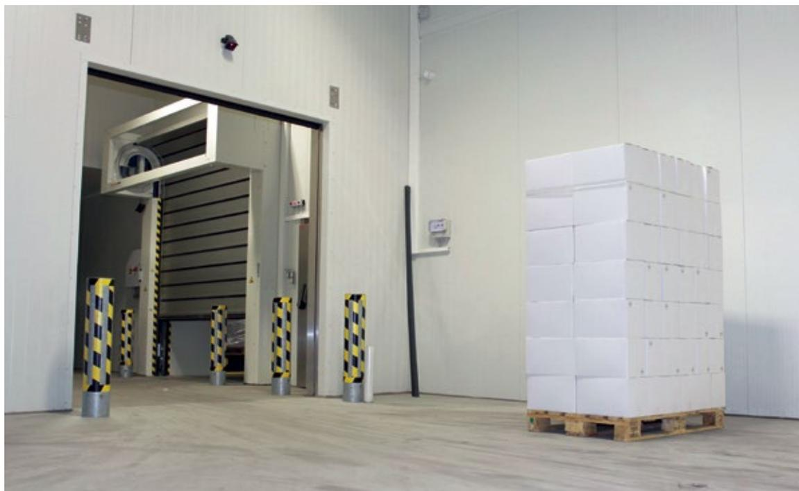
■ Abb.: Das neue Schnelllauf-Spiraltrakt minimiert Temperaturschwankungen und bildet mit einem weiteren Tor (EFA-SRT) eine Torschleuse.
