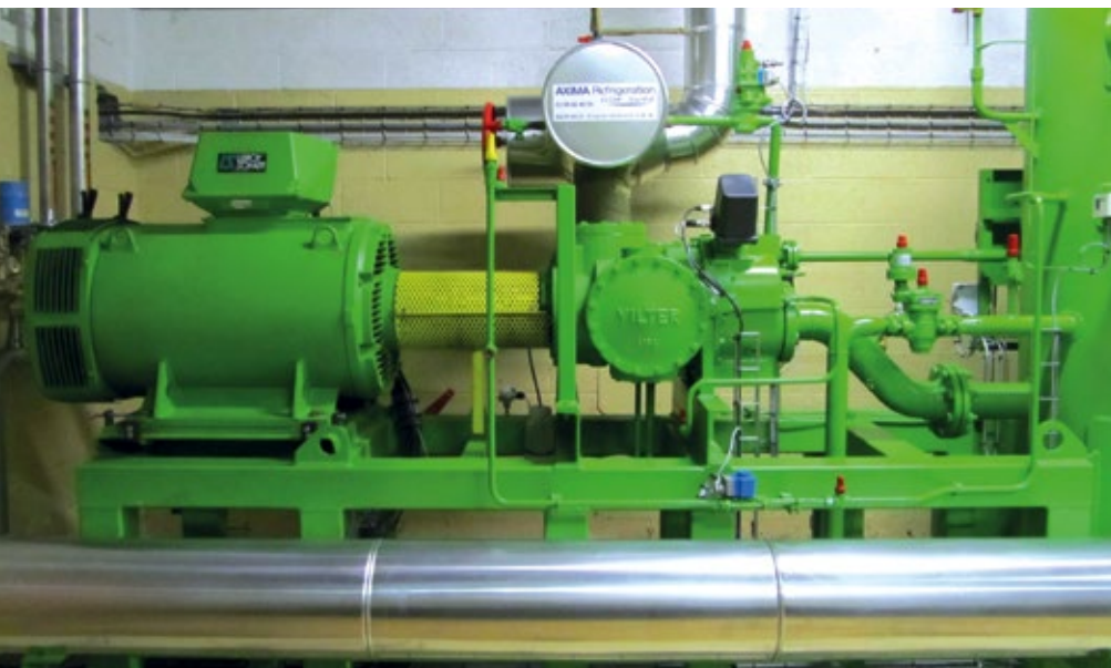
■ Abb. 1: Vilter Einschraubenverdichter, angetrieben von einem Dyneor PLSRPM Synchronmotor mit Permanentmagneterregung.
