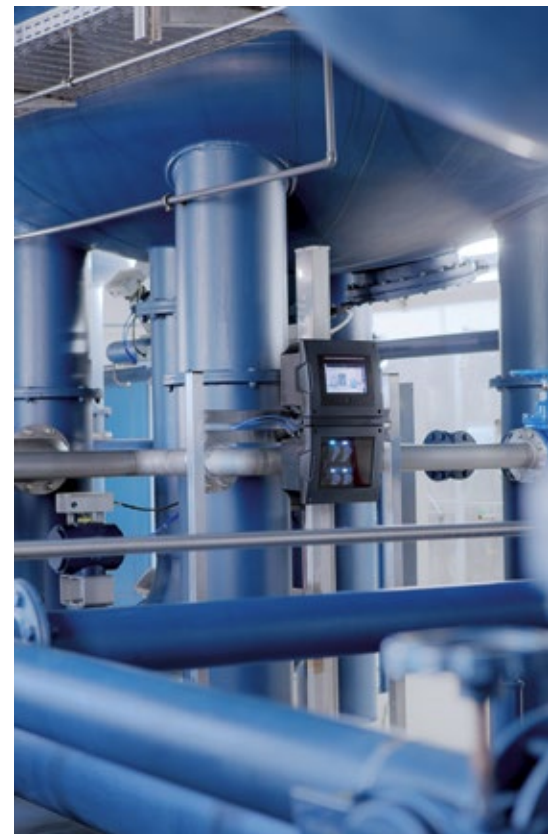
Abb.2: Das Online-Analyse-System Typ 8905 übernimmt die kontinuierliche Messung der Wasserparameter.
