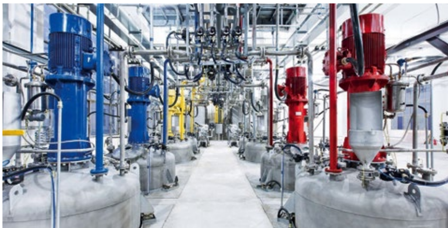
Abb. 1: Anlage für lösungsmittelbasierte Verpackungsdruckfarben
