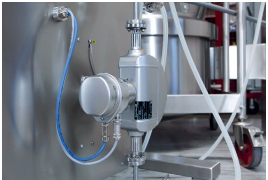
Abb. 2: Promass P erfüllt alle Hygiene-Anforderungen der Life Science Industrie.
