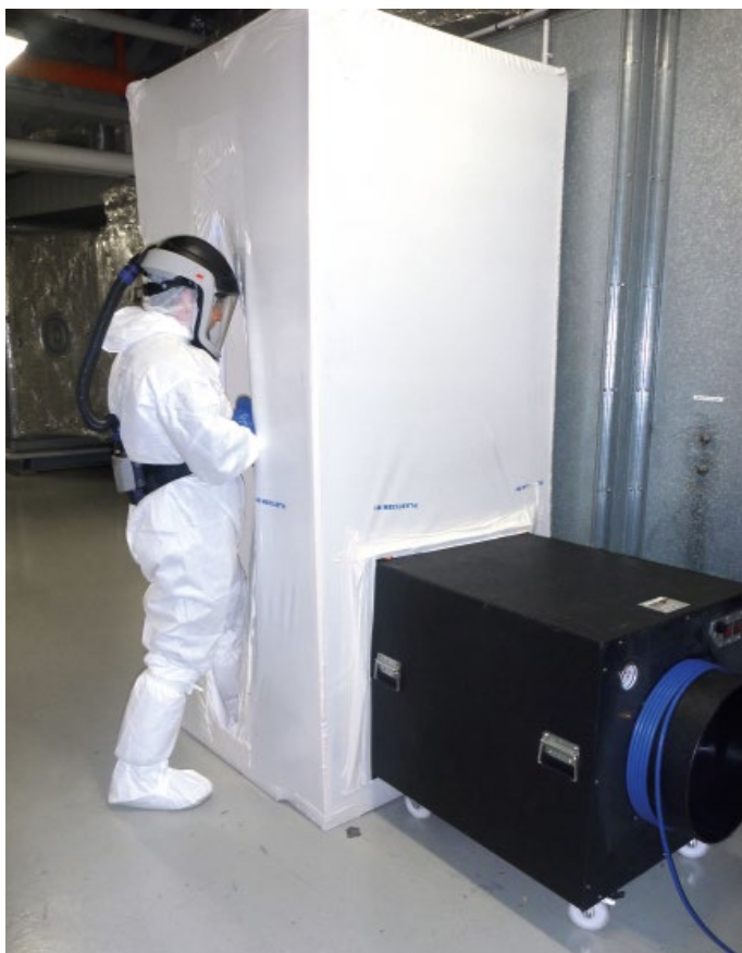
Abb. 2: Sicherheitsstruktur, um die Kreuzkontamination zu vermeiden
