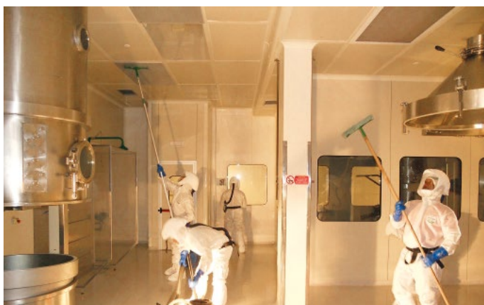
Abb. 3: Reinraumdekontaminationsarbeiten
