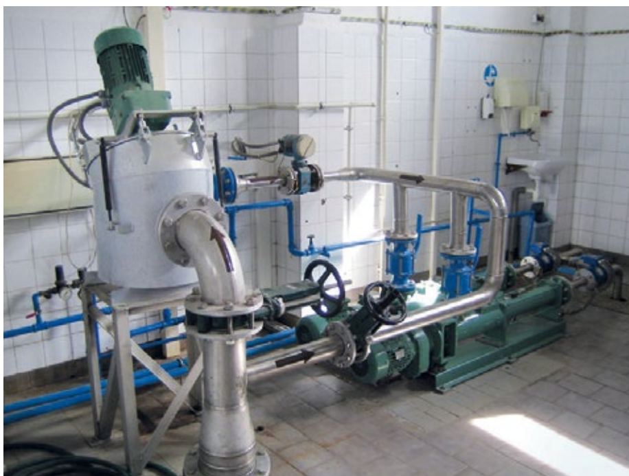
Abb. 3: Um eine möglichst große Angriffsfläche für die Bakterien zu bieten und zugleich ein Verstopfen zu vermeiden, empfiehlt es sich, je nach Material einen Zerkleinerer vor die Pumpe zu schalten. Der M-Ovas zeichnet sich hier durch eine hohe Robustheit und Schneideffizienz aus.
