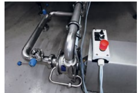
Abb.3: Um verschiedenen Produkteigenschaften gerecht zu werden, lässt sich die Drehzahl der Pumpen antriebe – somit die Pumpgeschwindigkeit – an einem Handgerät einstellen.
