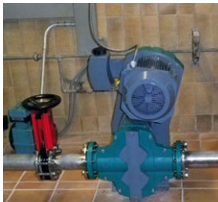
Abb. 4: Für hohe Fördervolumina, etwa zur Substratumwälzung, bieten sich die T.Agri-Drehkolbenpumpen an: Mit ihrem großen Förderraum bewältigen sie je nach Bauart bis zu 1.000 m³/h.
