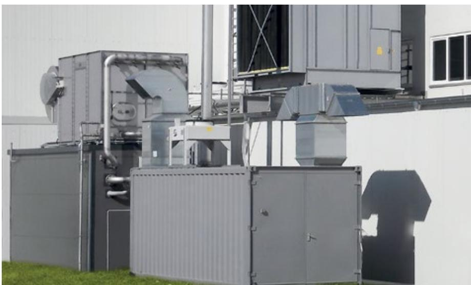
■ Abb. 2: KWKK-Anlage in Containerbauweise in Waren an der Müritz. Die modularen Systeme sind flexibel erweiterbar und bedürfen in der Regel keiner gesonderten behördlichen Baugenehmigungen.
