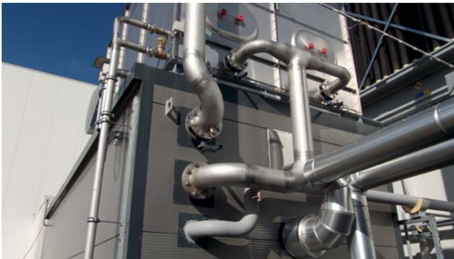
■ Abb.1: Die im Werk von Steinofen-Meister installierte KWKK-Anlage verfügt über ein BHKW mit 385/498 kW und eine AKM mit 147/251 kW Leistung. Amortisierung der eingesetzten Mittel: drei Jahre.
