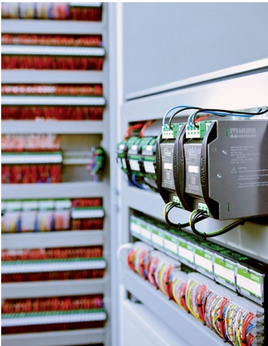
■ **Abb. 3:** Bei der neuesten Generation dreiphasiger Netzgeräte der Baureihe „Emparro“ von Murrelektronik konnte ein Wirkungsgrad von nahezu 95 % bei Vollast realisiert werden.
