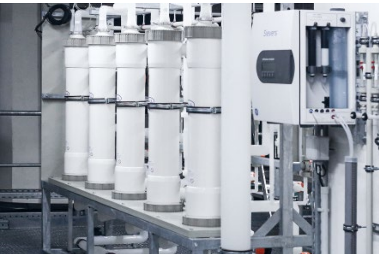
Abb. 2: Die Reinstwasser-Membranentgasung zur Sauerstoff-Entfernung.
