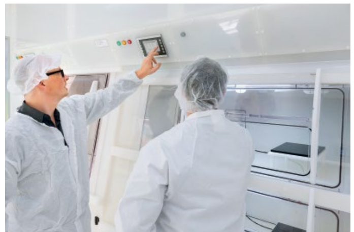
Abb. 3: Über integrierte Touchdisplays wird die Lüftungs- und Versorgungstechnik an den Arbeitsplätzen individuell gesteuert.
