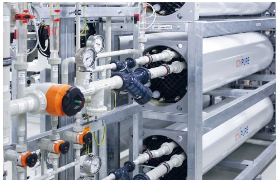
Abb. 1: Die Erzeugung des Reinstwassers erfolgt durch eine Kombination aus Umkehrosmose und Elektrodeionisation.
