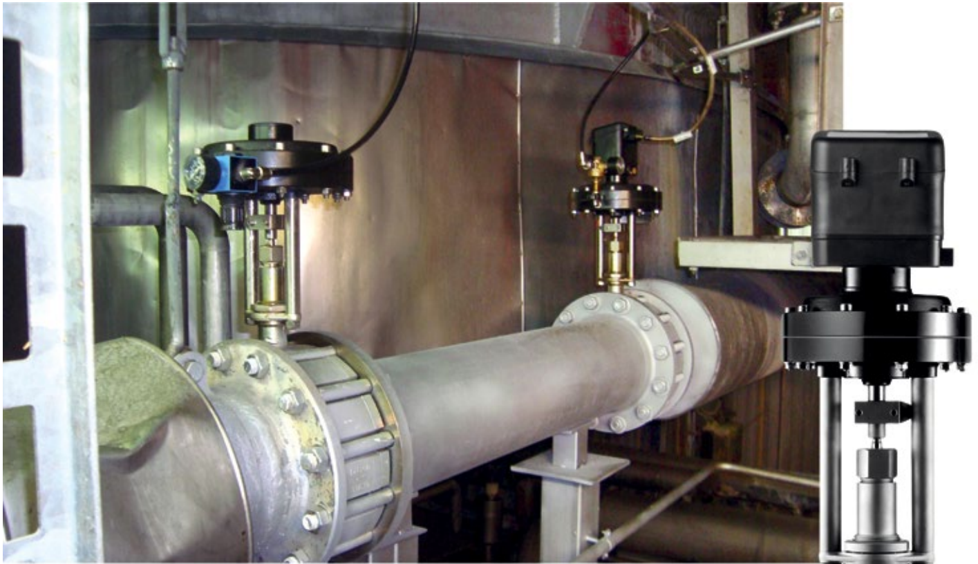
■ Abb. 1: Die geringe Baugröße und der damit wesentlich geringere Platzbedarf für das Gleitschieberventil waren wichtige Entscheidungskriterien für Eichbaum, auf diese Ventile im Sudhaus bzw. Filterkeller zu setzen.
