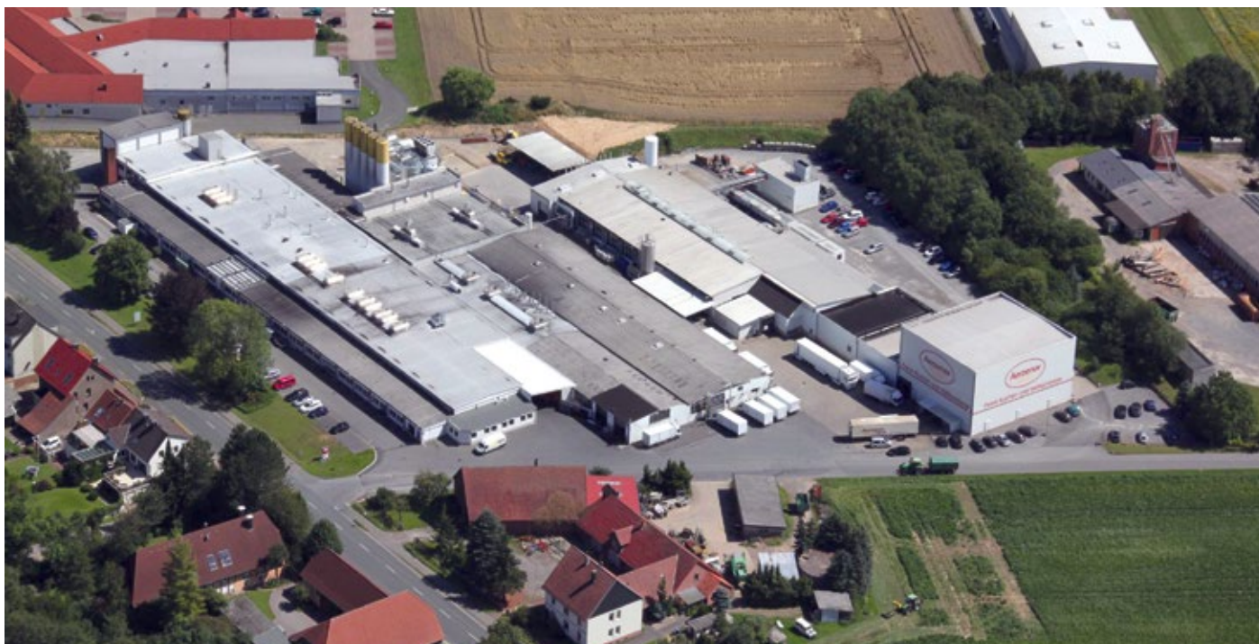
■ Abb. 3: Rund 200 Mitarbeiter arbeiten für die Aertzener Brot und Kuchen GmbH. Der moderne Produktionsstandort der Mestemacher-Unternehmensgruppe unterhält ein eigenes Blockheizkraftwerk.
