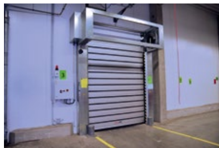
■ Abb. 2: Neun Schnellauftore von Efaflex versehen ihren Dienst bei August Jaeger Nachfolger. Das Tor zum Molkereibereich absolviert täglich 300-500 Öffnungszyklen.
