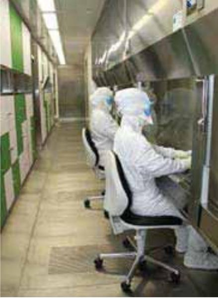
Abb. 2: Rechter Herstellungsraum, Team an 2 Bänken, Laminarflow von der Decke, Doppelboden V4A
