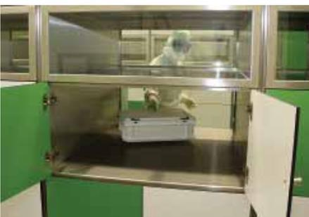
Abb. 3b: Mittig liegender Versorgungsflur GMP Klasse „B“, Materialübergabe in den Herstellbereich
