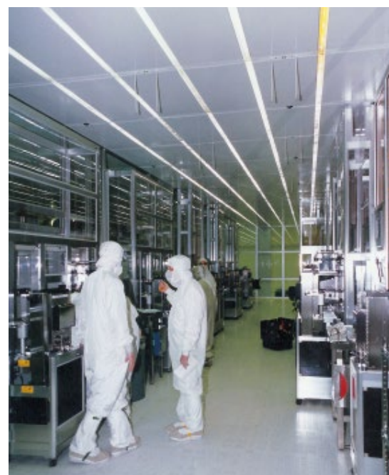
Abb. 2: Deckenionisatoren im Laminaflowbereich
