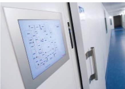
Abb. 3: Eine klare Signalisierung der Türzustände mit ergänzenden Informationen kann ebenfalls viel bringen.
