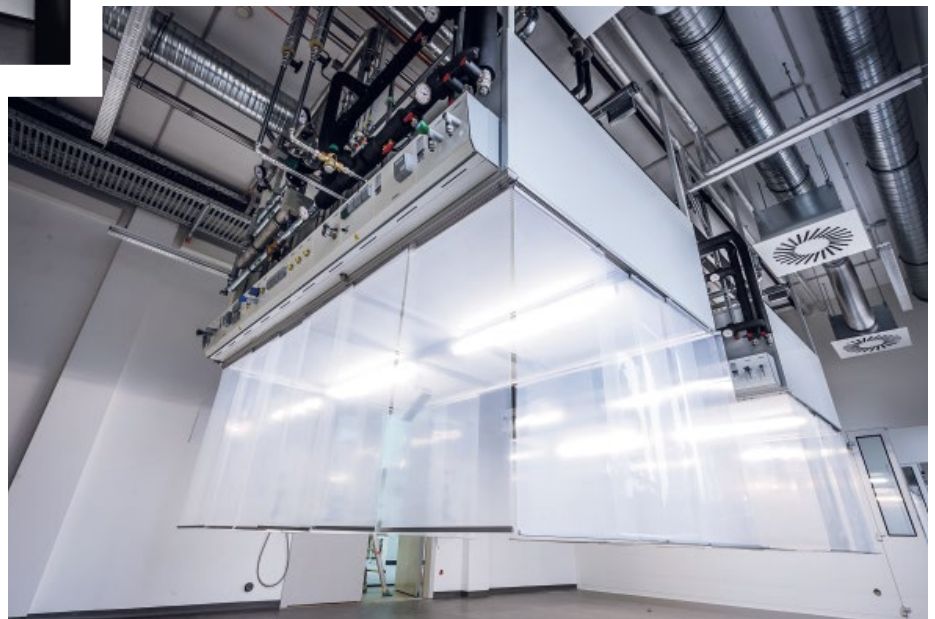
Abb. 1: Medieninstallation über der Lasertisch-Konditioniereinheit
