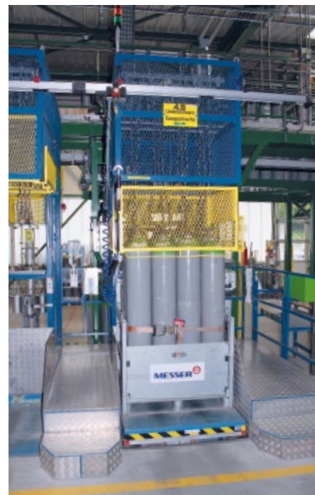
Abb. 4: Reinstgasversorgungsflaschen bei der Fa. Messer/Lenzburg/Schweiz. Nur in Flaschen mit einwandfreien inneren Oberflächen können die strengen Spezifikationen für Reinstgase eingehalten werden
