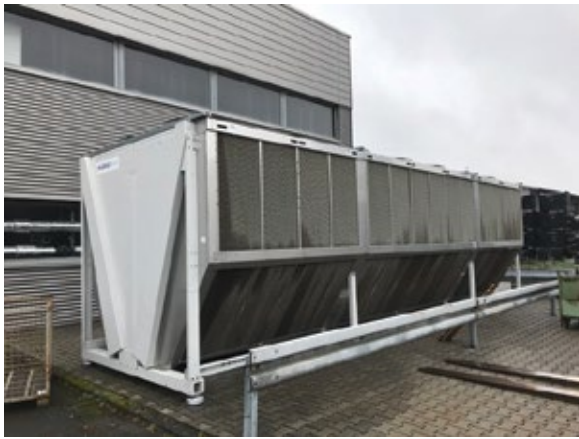
Abb. 3: trockenes Rückkühlwerk mit adiabater Vorkühlung
