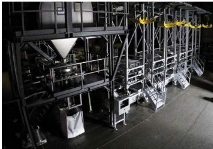
Abb.: Montage der 8 m hohen Mischanlage
