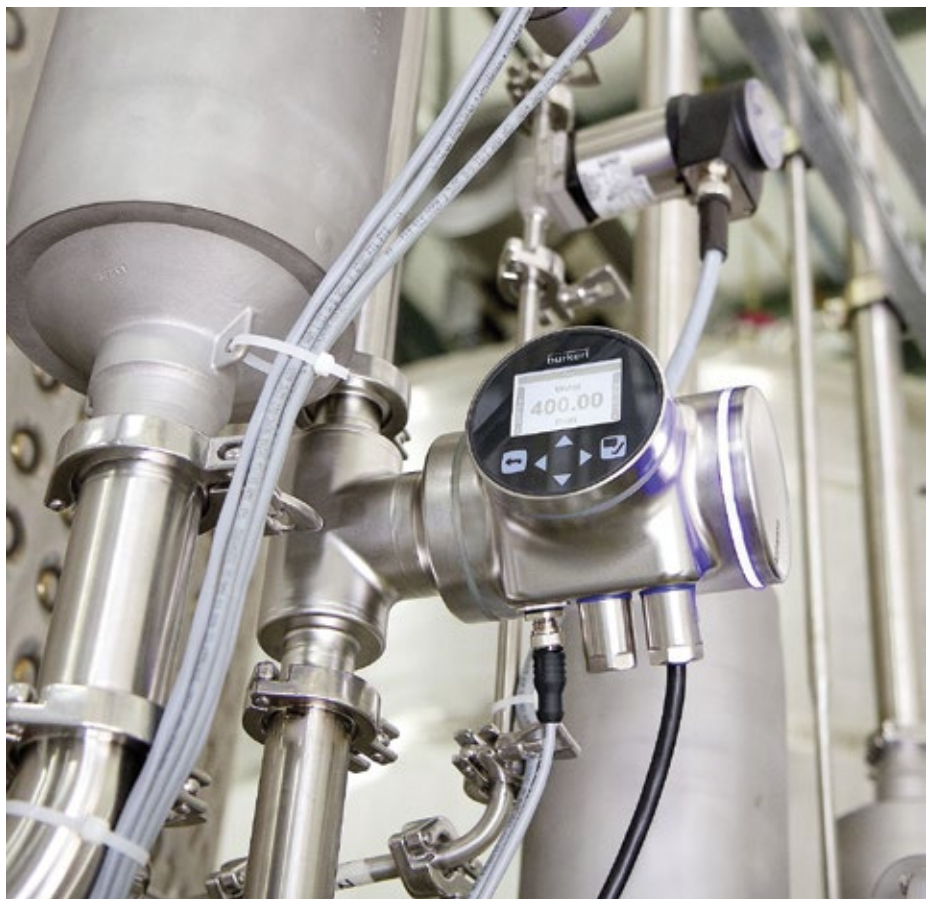
Abb. 1: In der pharmazeutischen Industrie haben sich die SAW-Durchflussmesser bereits in vielen, ganz unterschiedlichen Anwendungen bewährt, z.B. bei der Durchflussmessung von teurem Reinstwasser.
