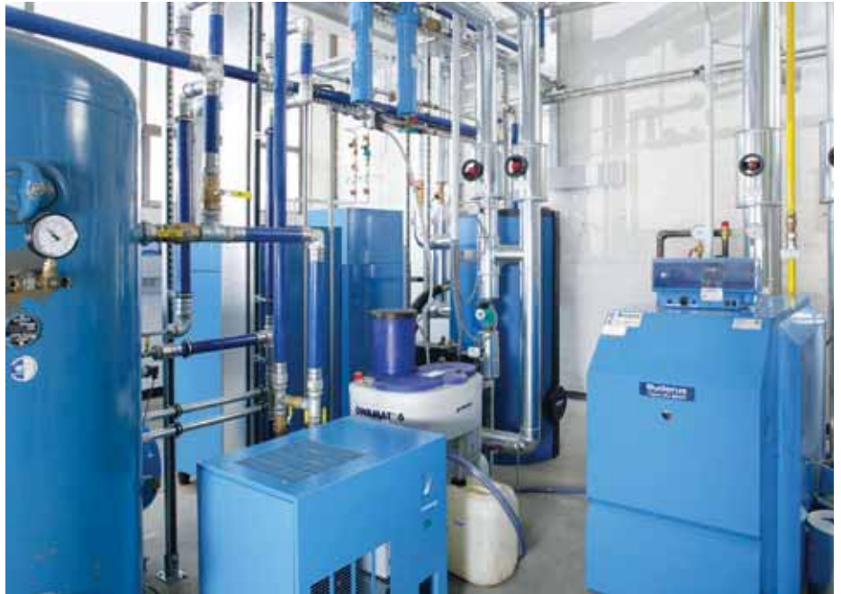
Abb. 1: Die Wärme, die bei der Druckluftherzeugung entsteht, kann z. B. zu Heizzwecken genutzt werden – wie hier am Firmensitz von Boge in Bielefeld.
