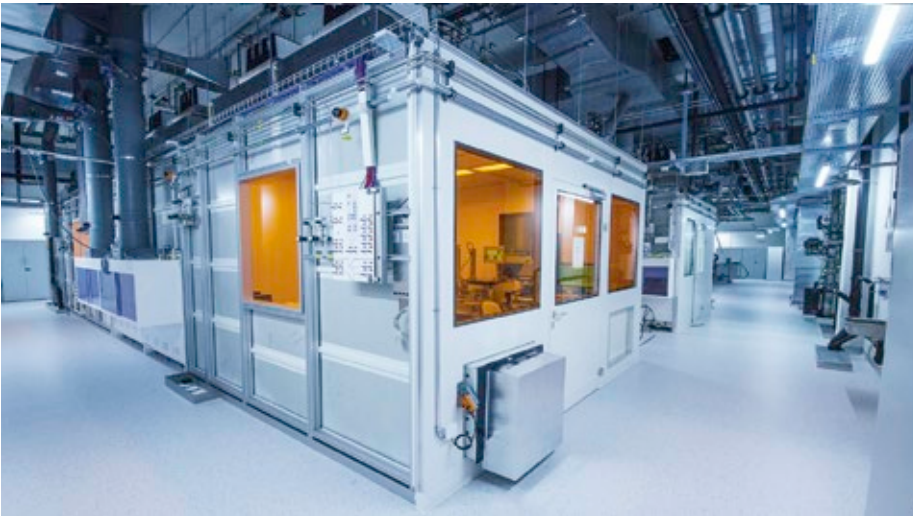
Abb. 1: Blick vom Grauraum auf den fingerartig aufgebauten inneren Reinraumbereich, von dem im Vordergrund der Lithografieringer und weiter hinten der Nasschemieabschnitt zu erkennen sind.
