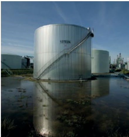
Abb. 2: Der Umgang mit wassergefährdenden Stoffen umfasst das Herstellen, Behandeln, Verwenden, Lagern, Abfüllen und Umschlagen sowie das Fortleiten in Rohrleitungen.
