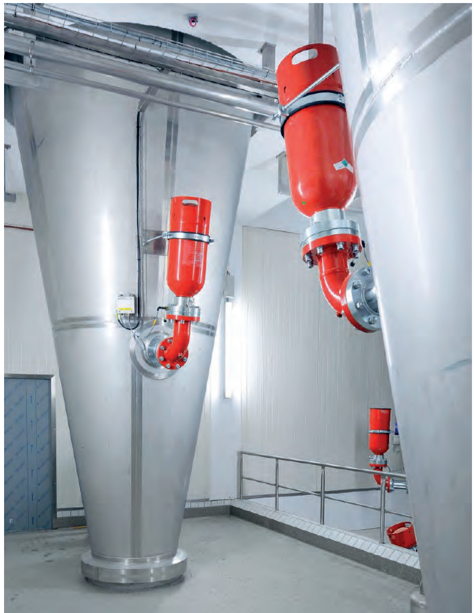
Abb. 2: Löschmittel zur Explosionsunterdrückung (Aktives Explosionsschutzsystem)
