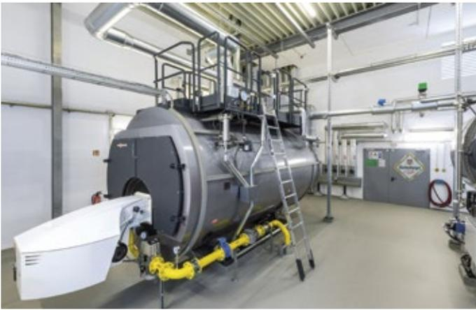
■ Abb. 2: Viessmann Hochdruck-Dampferzeuger Vitomax HS in Low-NOx-Ausführung und thermische Vollentgasung TWA-V.
