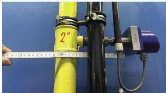
■ Abb. 1: Der Differenzdruck Massenstrom-Durchflussmesser DeltaflowC, installiert an einer Brenner-Gasleitung.
