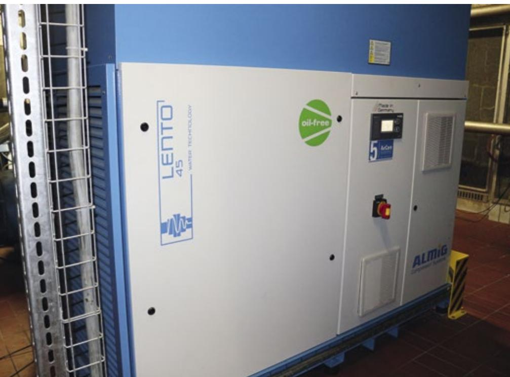
■ Abb. 1: Der ölfreie, wassereingespritzte Schraubenkompressor von Almig stellt die in der Lebensmittelindustrie geforderte Druckluftqualität der Klasse 0 und eine energieeffiziente Prozesstechnologie sicher.
