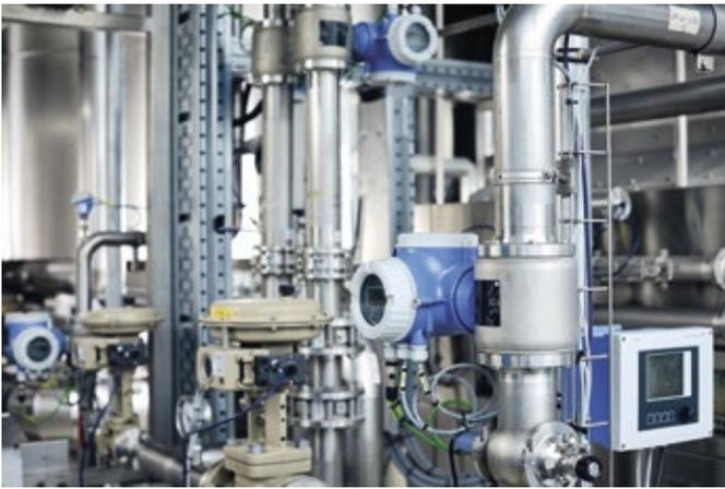
■ **Abb. 2:** Jeder Energieverbraucher im Sudhaus ist mit Energiezählern ausgerüstet: die Mischbatterie für das Wasser der Schrotmühle mit magnetisch-induktiven Durchflussmessern Promag H und Temperatursensoren.
