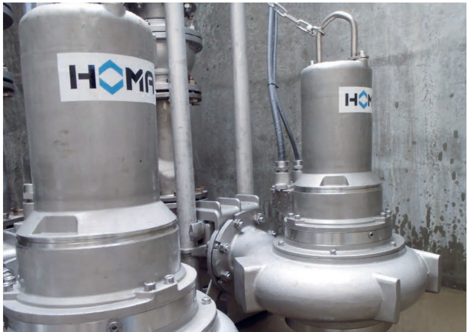
Abb. 2: Die verschiedenen Edelstahl-Tauchmotorpumpen der Baureihen CH, CTP, CMX, CV, CVX, CK der Homa Pumpenfabrik – konzipiert mit Druckanschlüssen 2“ bis DN 150 – eignen sich für den Dauerbetrieb in der chemischen Industrie und bei der Entsorgung chemisch belasteter Abwässer. ►
