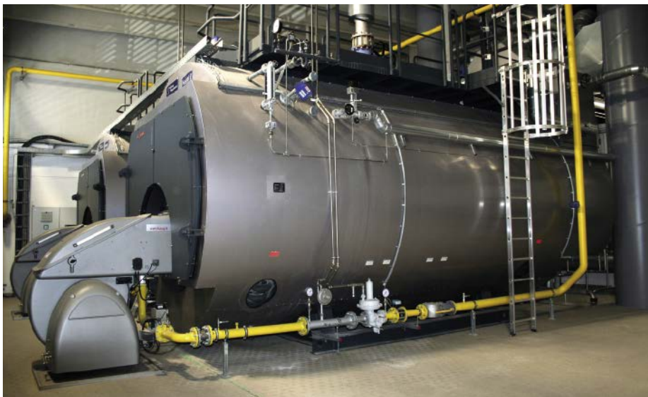
■ Abb. 2: Jeweils 15 t Dampf pro Stunde liefern die beiden Hochdruck-Dampferzeuger in der Käserei in Neumünster. Die beiden Dampferzeuger Vitomax HS überzeugen mit besonders niedrigen NOx-Werten.
