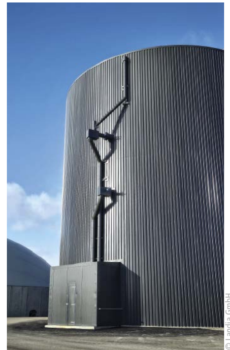
■ Abb. 3: Da sich beim GasMix alle mechanischen Komponenten außerhalb des Prozessbehälters befinden, muss der Fermentationsbehälter zur Wartung oder Reparatur des Systems nicht geöffnet werden.
