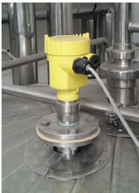
■ Abb. 2: Früher geschahen viele Umschlagprozesse manuell. Heute messen u.a. freistrahlende Radarsensoren kontinuierlich den Füllstand in den Lagertanks, aber auch in den Autoklaven.
