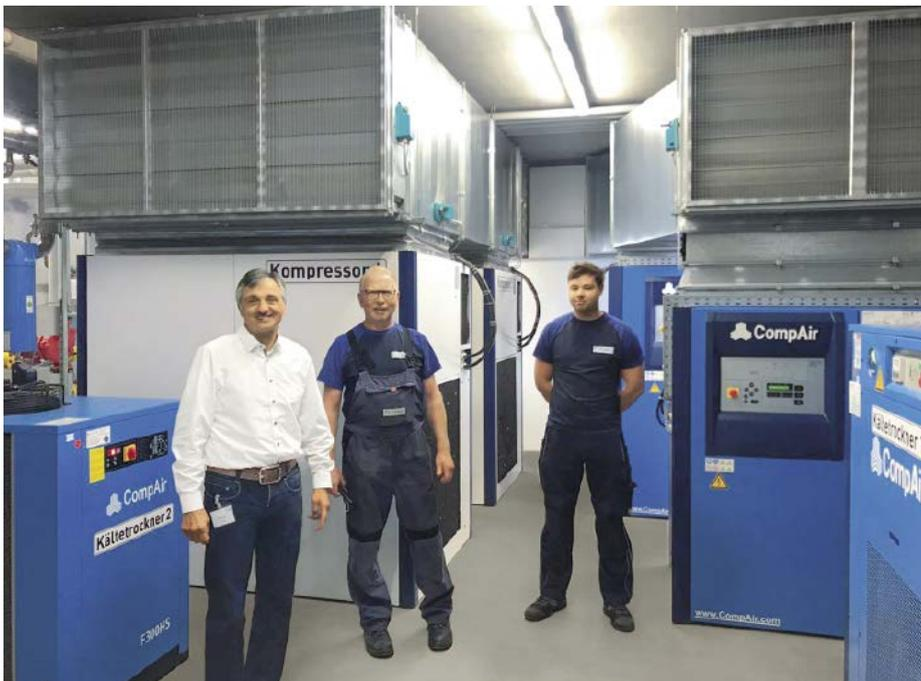
■ Abb. 3: Josef Friedl, Geschäftsführer der A&F Drucklufttechnik (links), projektierte eine Ergänzung der Druckluftstation um einen weiteren drehzahleregelten Schraubenkompressor der Typenreihe D75H RS.
