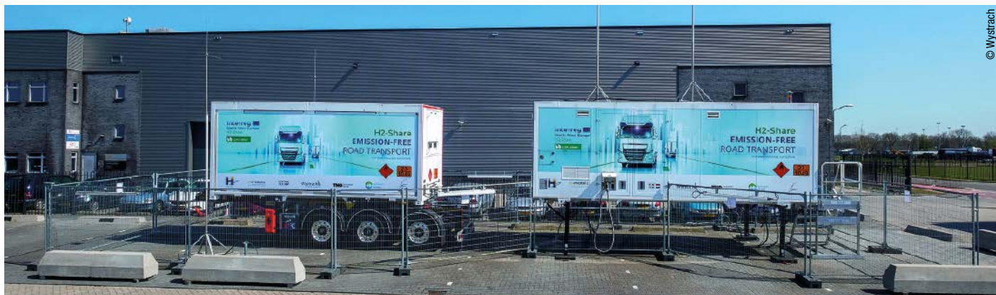
Abb. 1: Der WyRefueler ist eine Tankanlage mit niedrigem Energieverbrauch für die Befüllung von Wasserstoff-Tanksystemen. Ob Busse, Lkw, Züge, Baumaschinen oder Stapler: Jedes druckwasserstoffbetriebene Fahrzeug kann damit betankt werden.
