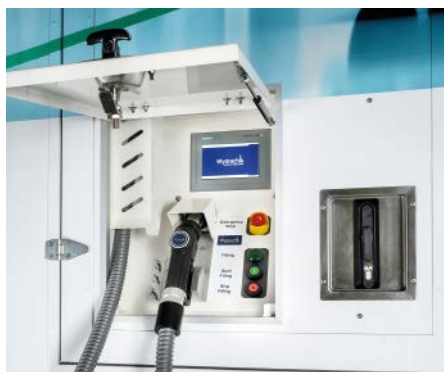
Abb. 2: Das Bedienterminal der Tankstelle im ATEX-konformen Gehäuse.
