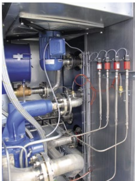
Abb. 2: Der Luft-Luft-Nachkühler ist in das Aggregatgehäuse integriert.
