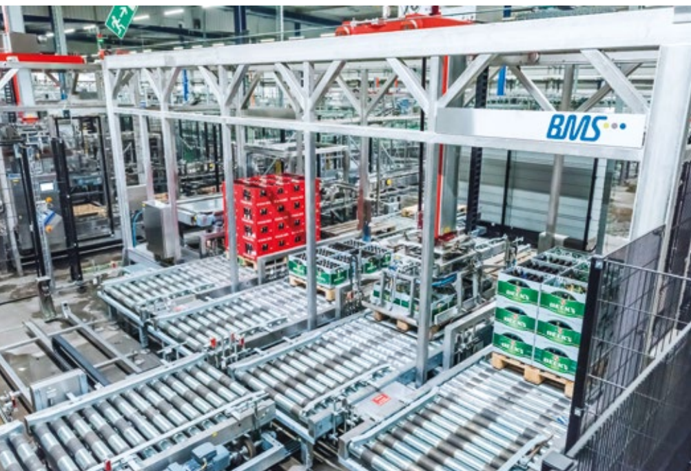
■ Abb. 3: Die Palettierer der Sortieranlage wurden alle als Portalroboter ausgeführt. Verbaut wurden ein Entlader mit zwei Achsen, ein Belader für die drei Haupt- und ein Belader für die vier Nebensortenkästen (im Bild).
