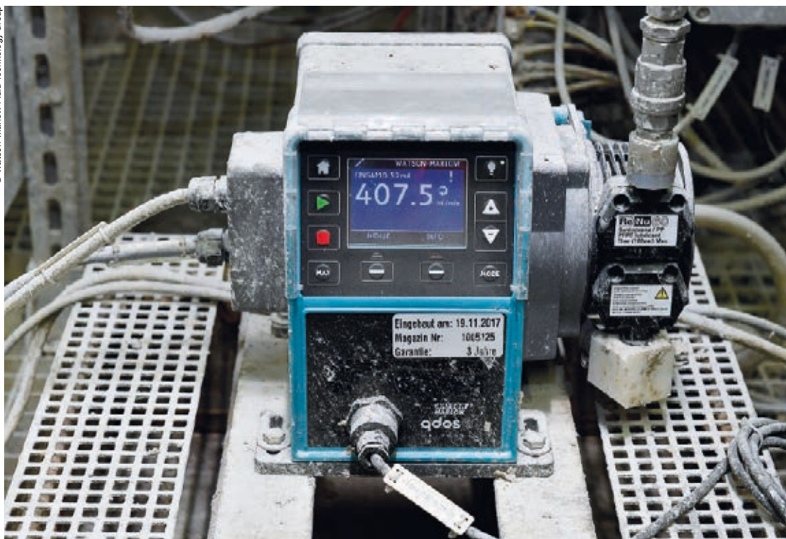
Abb. 2: An der Nasspartie der Kartonmaschine „KM3“, fördert die Qdos Dosierpumpe einen chemischen Entschäumer in das ablaufende Siebwasser. Hinsichtlich Dosiergenauigkeit und Wartung bietet die Schlauchpumpe eine erhebliche Verbesserung gegenüber der zuvor verwendeten Membranpumpen.
