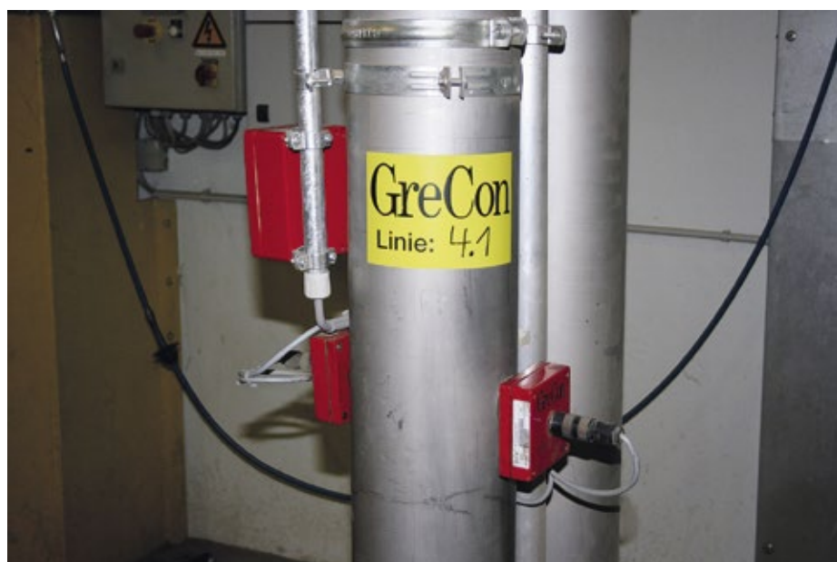
Abb. 3: Die Teeverarbeitung führt zu sehr starken Anhaftungen in Transportleitungen und den flächenbündig installierten Melder-Optiken. Eine regelmäßige Reinigung durch den Betriebselektriker sorgt für eine permanent hohe Erkennungsleistung.
