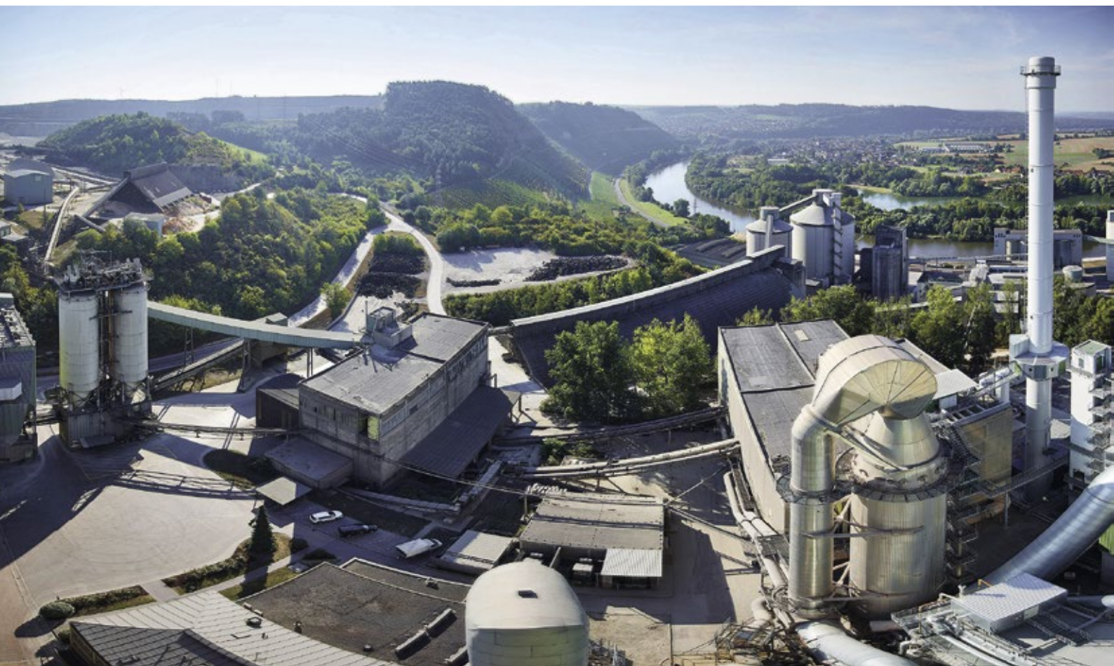
Abb. 1: Die Beumer Group lieferte an HeidelbergCement eine vollautomatische Anlage, die unterschiedlich große und schwere Reifen dosiert, vereinzelt und zum Drehrohrfördereinlauf fördert.
