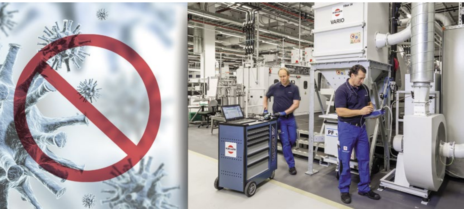
Abb. 1: Leistungsfähige Absauganlagen, z. B. mit KLR-Filterelementen von Keller Lufttechnik, filtern Feinstaub aus der Luft und halten auch luftgetragene Pilze, Bakterien und Sporen hochprozentig zurück.
