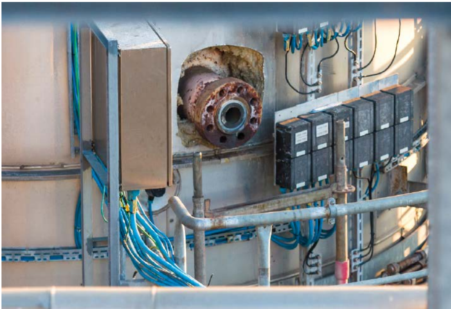
Abb. 5: In der Öl- und Gasindustrie herrschen raue Umgebungsbedingungen für Sensoren und Korrosion kann das zum Problem werden.
