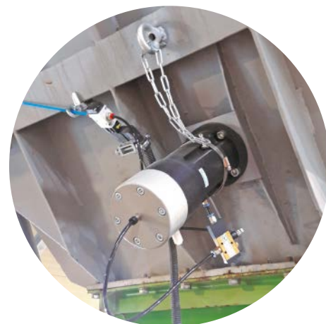
Einsatz des Klopfers an einem Silo eines Kohlekraftwerks.
