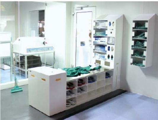
**Abb. 3:** Der Zugang zum eigentlichen Reinraumteil erfolgt über eine Schleuse in den Bereich der höchsten Reinheitsklasse.
