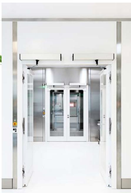
**Abb. 3:** Das Türsystem mit automatischem Antrieb wurde mit einer Schleusensteuerung ausgestattet.
