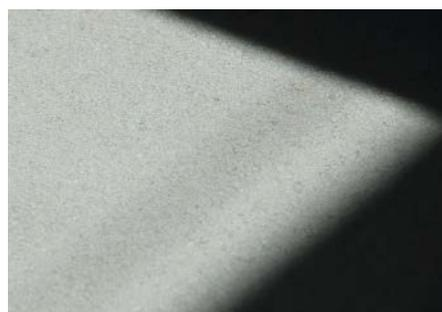
Abb. 2: Alle Terrazzo-Varianten bestehen aus einem Granulat, das direkt vor Ort mit einem Bindemittel zu einem homogenen Material vermischt und auf den Estrich aufgetragen wird.
