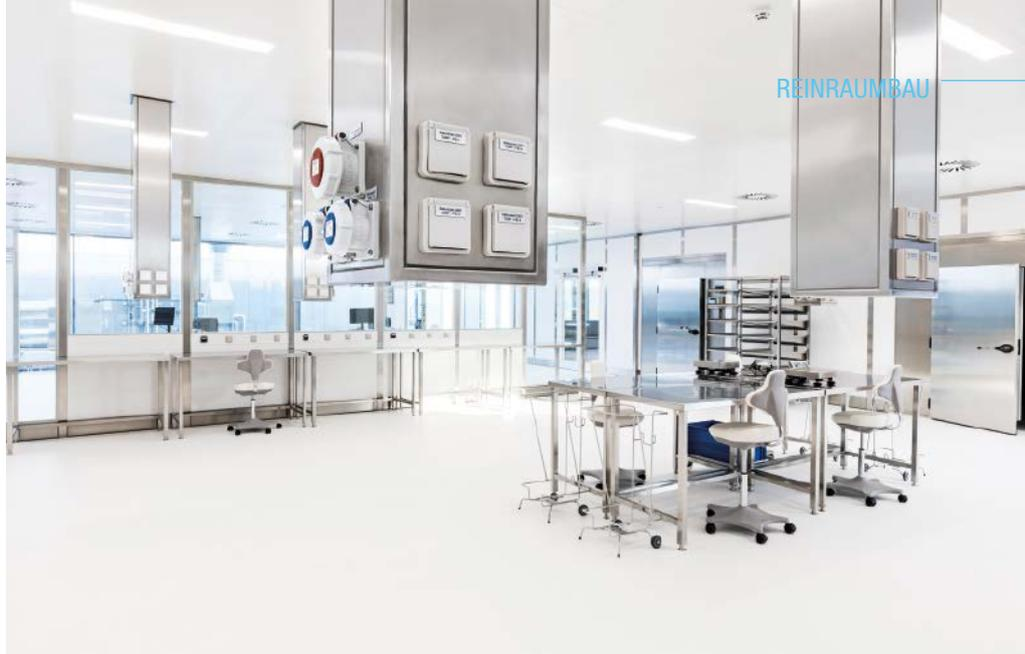
**Abb. 2:** Frei schwebend installierte Edelstahl-Medien-säulen stellen die Strom- und Medienversorgung sicher.
