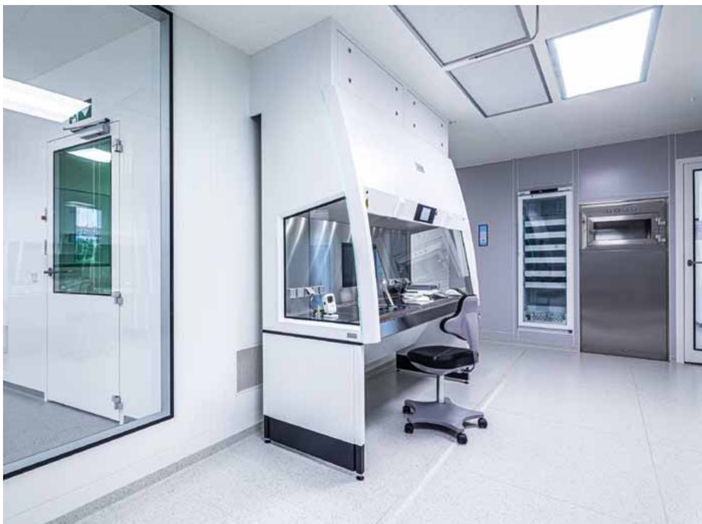
Abb. 4: Patentierte Becker QuickOut-Schleuse: Beladeseite im GMP „B“ Bereich (im Bild rechts)
