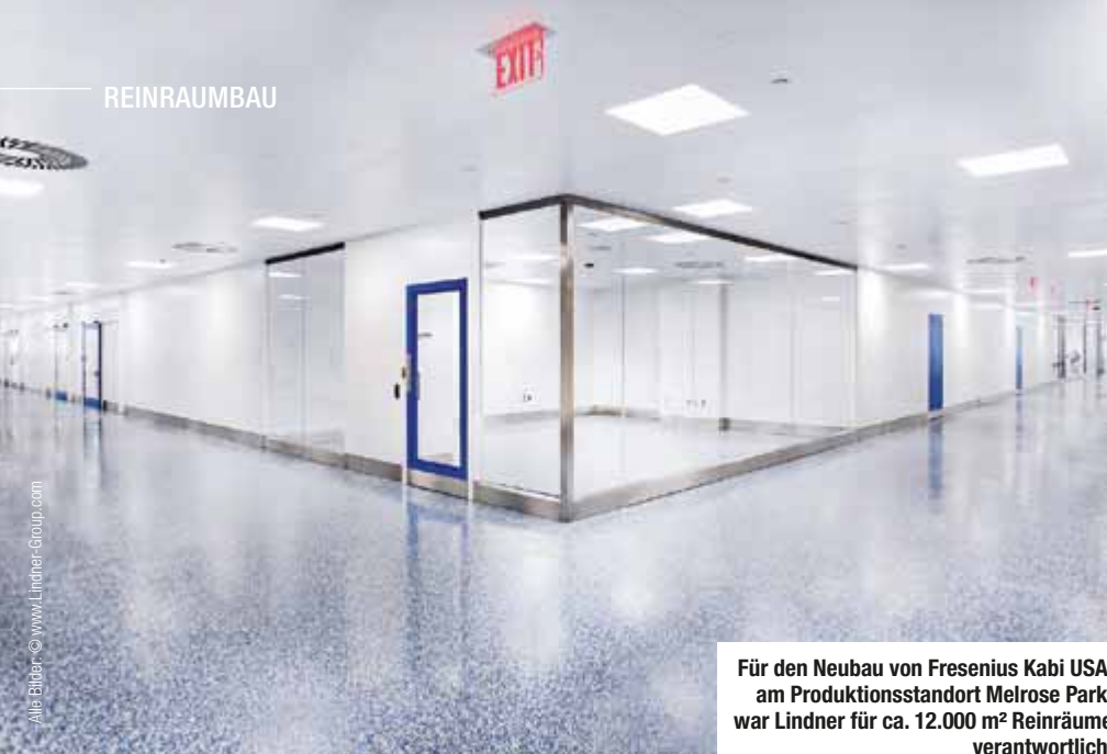
Abb. 1: Speziell für dieses Projekt entwickelte Lindner die Slide Pharma 80, ein flächenbündiges Schiebetürsystem mit einem lichten Durchgangsmaß von bis zu 1.700 mm.
