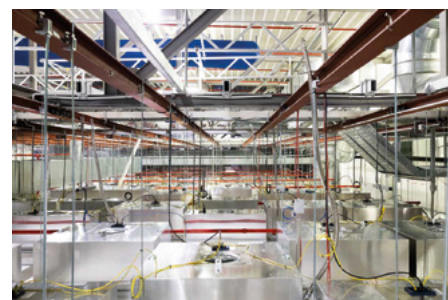
Abb. 1: Das Plenum über dem Reinraum
