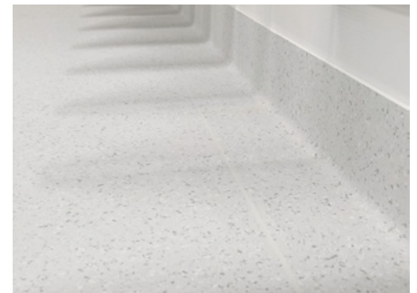
Abb. 3: Dank der dauerhaft UV-vernetzten Oberflächenvergütung und der Ausbildung von Hohlkehlen verfügt der Belag über eine exzellente Reinigungsfähigkeit sowie eine sehr hohe Beständigkeit gegenüber mechanischen Belastungen und chemischen Angriffen.
