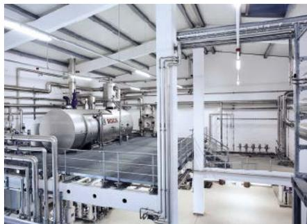
■ **Abb. 2: Der Spitzenlastkessel ist ein wichtiger Bestandteil des redundanten Aufbaus der Energiezentrale.**
