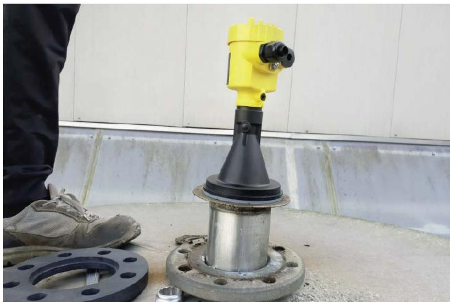
■ **Abb. 2:** Für alle Beteiligten in der Maismühle war die berührungslose Messung ein Pluspunkt. So mussten die Silos für die Montage der Sensoren nicht extra entleert werden.
