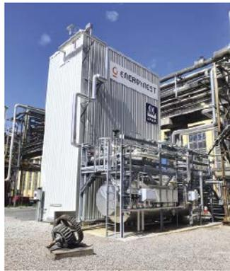
■ **Abb. 2: Die Wärmespeichermodule bei Yara in Porsgrunn mit Verkleidung und Boiler.**
