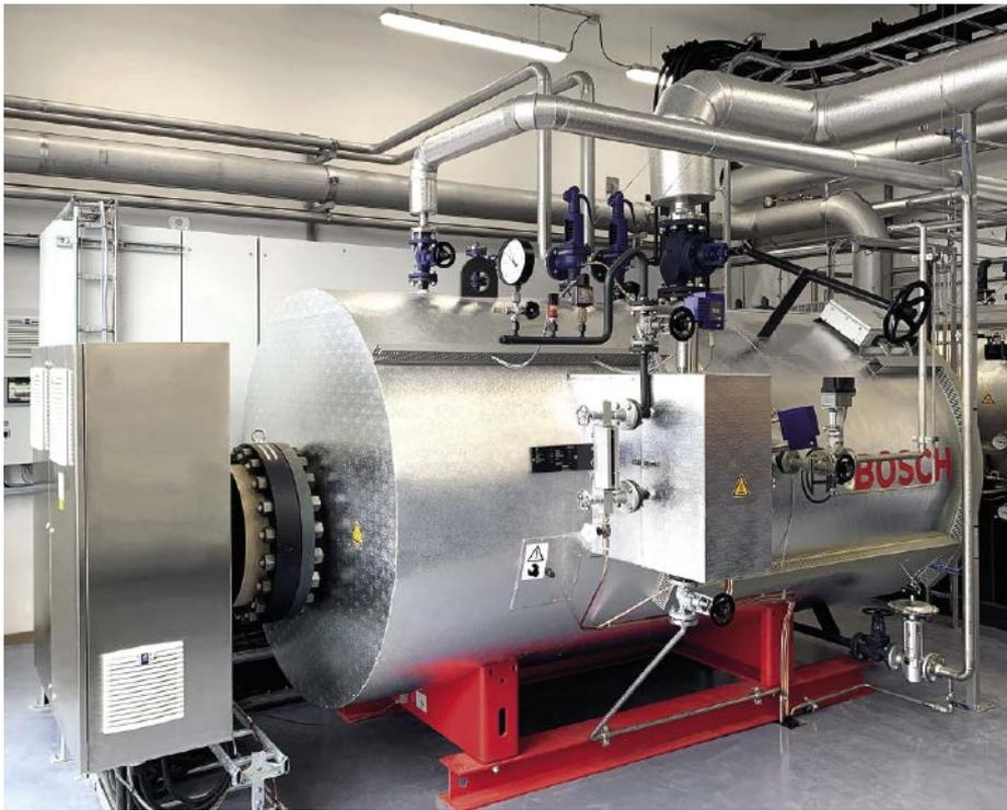
■ **Abb. 3:** Bei Betrieb mit Grünstrom wird der Elektrodampfkessel (ELSB, Electric Steam Boiler) zu einem wichtigen Baustein in der Dekarbonisierung der Produktion.
