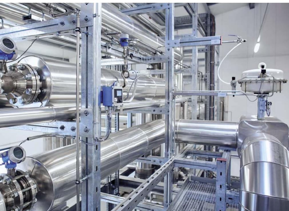
Abb. 1: Vortex-Durchflussmessgeräte und Dampfrechner Engycal RS33 (im Zentrum): Zur Dampfmessung kommen andere Messinstrumente als in der Milchverarbeitung zum Einsatz.
