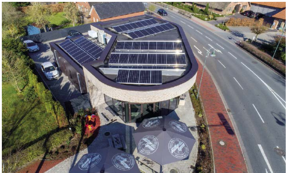
Abb. 2: Die Bäckerei-Filiale von Müller & Egerer in Sande vermeidet jährlich ca. 10 t CO 2 , die Filiale in Wiefelstede (Bild) spart sogar rund 13 t CO 2 -Emissionen jährlich ein.
