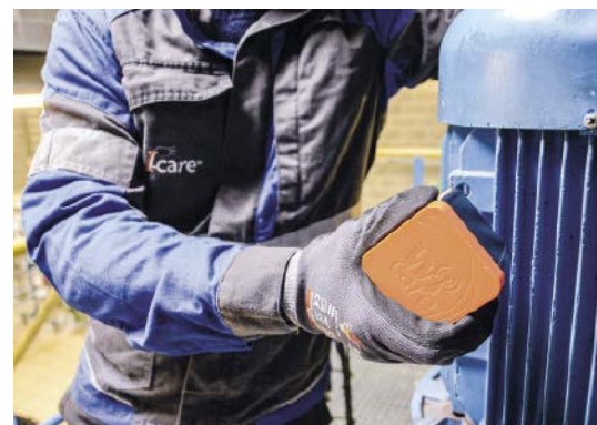
■ Abb. 2: Nur wenn man weiß, welche Schadensfälle detektiert werden sollen, kann die richtige Sensorik ausgewählt und installiert werden.
