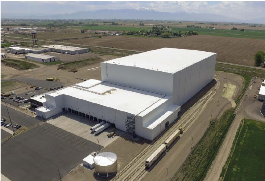
■ Abb. 2: Für 90.000 Palettenstellplätze benötigte Newcold nur 14.400 m 2 , denn die Ware wird mit Regalbediengeräten auf 14 Ebenen verteilt.
