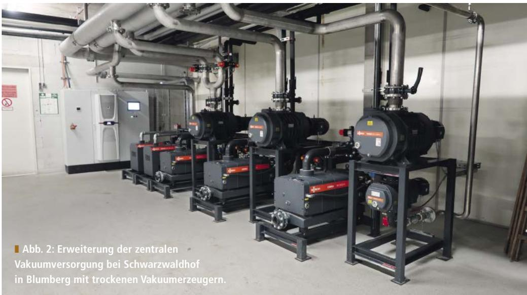
■ Abb. 2: Erweiterung der zentralen Vakuumversorgung bei Schwarzwaldhof in Blumberg mit trockenen Vakuumerzeugern.
