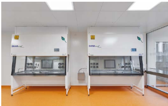
Abb. 2: Die Beläge sind durch ihre dichte, geschlossene Oberfläche medienbeständig und einfach zu reinigen.
