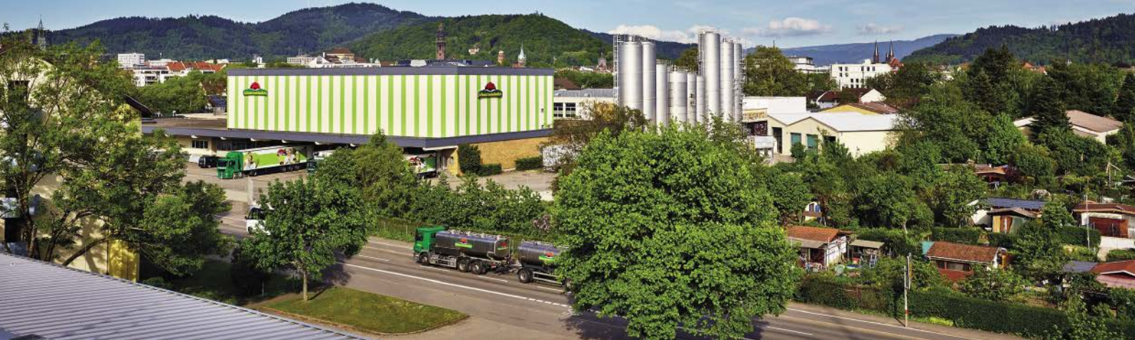
■ Abb. 1: Schwarzwaldmilch nutzt die Abwärmeauskopplung und -einspeisung aus der industriellen Kälteerzeugung und dem Abwasserstrom im Rahmen des Projektes Wärmeverbund Freiburg-Süd der Badenovawärmeplus.
