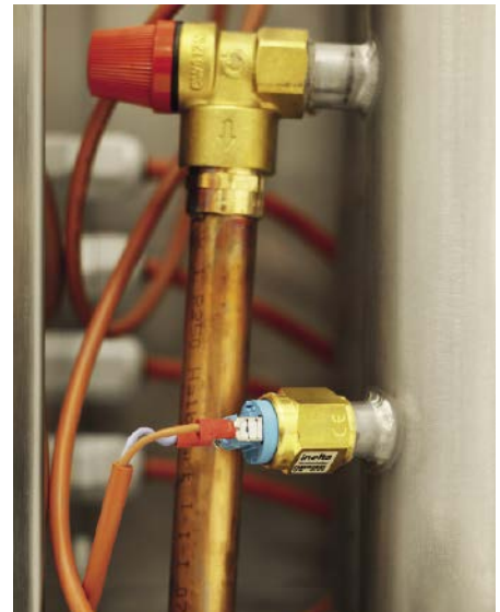
■ Abb. 3: Der Druckschalter von Inelta Sensorsysteme am Steigrohr des TD13.
