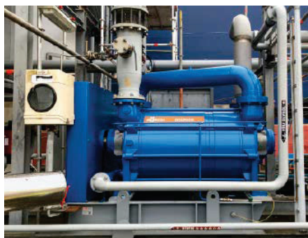
Installation der Dolphin Flüssigkeitsring-Vakuumpumpe in der Dampfrückgewinnungsanlage im Hafen von Göteborg.
