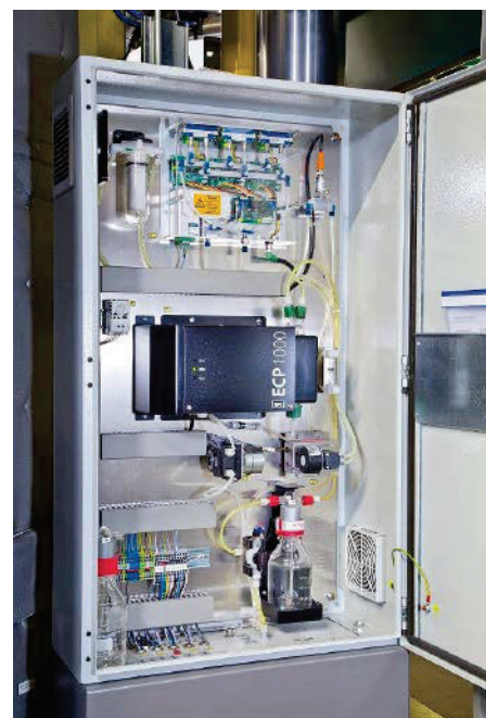
Die Flowevo-Sensoren werden in der von Burkhardt entwickelten und gebauten Analyseeinheit eingesetzt, die kompakt konstruiert und einfach austauschbar ist.
