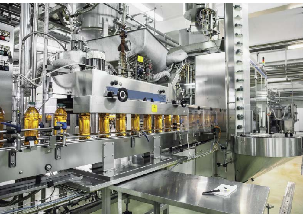
■ Abb. 1: An Anlagen wie der Fruchtsaftabfüllung werden besondere Ansprüche an hygienischen Aufbau, leichte Reinigung und Produktreinheit gestellt.
