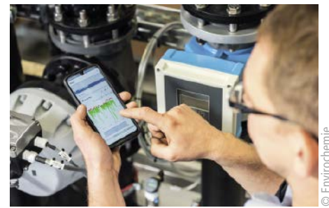
■ Abb. 3: Die digitale Service Plattform Waterexpert von Envirochemie erleichtert den Anlagenbetrieb und liefert Handlungsempfehlungen zur Anlagenoptimierung.
