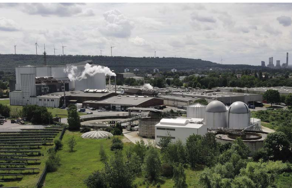
■ Abb. 1: Envirochemie betreibt für einen Kartoffelverarbeiter die wassertechnischen Anlagen und hat in mehreren Optimierungsphasen den Verbrauch von Strom, fossilen Energieträgern und Frischwasser gesenkt.
