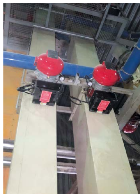
■ Abb. 2: Als chemische Entkopplung eingesetzt stoppt das IPD-System von BS&B die Ausbreitung einer möglichen Staubexplosion in den Schächten eines Becherelevators.
