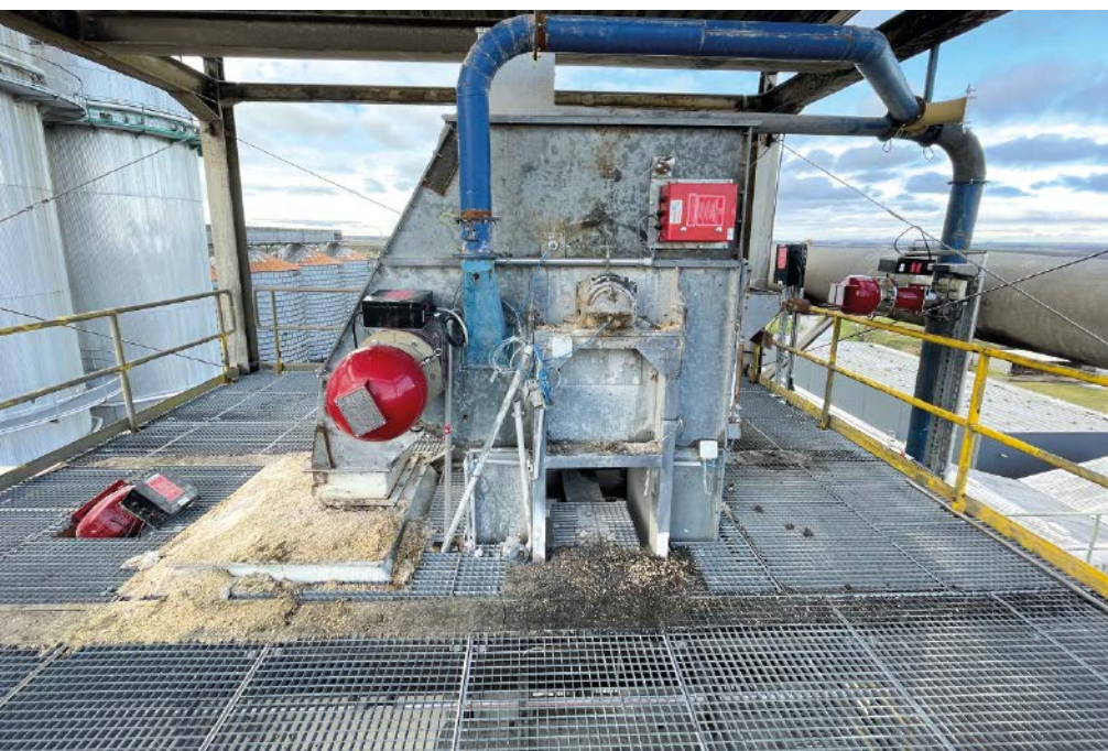
■ Abb. 1: Sollte im Kopf dieses Becherelevators eine Staubexplosion entstehen, unterdrückt sie das IPD-System von BS&B (links) in Sekundenbruchteilen mit einem chemischen Löschmittel.
