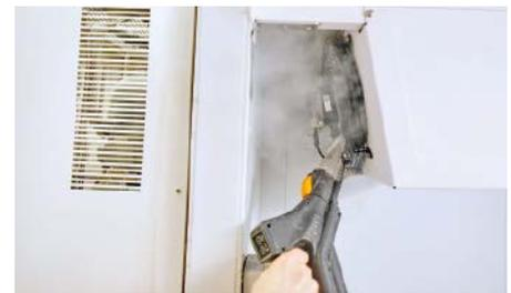
■ Abb. 4: Selbst empfindliche Technik wie den Verdampfer im Kühlhaus reinigt Sven Jansky mit dem Beam-Gerät besonders schonend.
