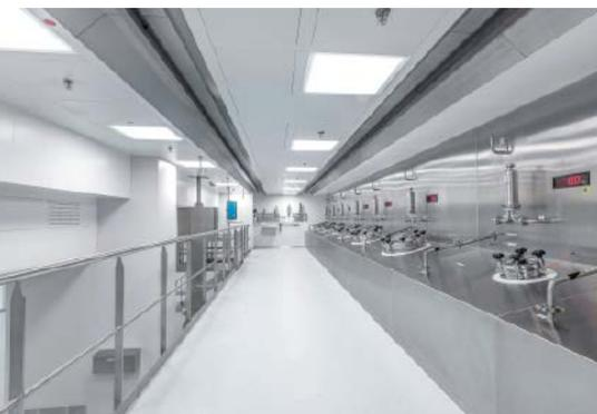
**Abb. 4: Pufferansatzraum: Integration einer Bedienbühne in den Reinraum, sämtliche Installationen im Technikbereich dahinter, nur notwendige Ausstattungen im Reinraum integriert (z.B. Handlöcher großer Ansatzbehälter)**
