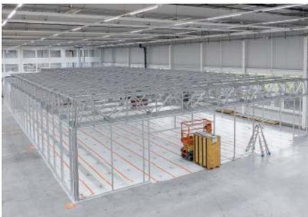
Der Reinraum ist in Modulbauweise konzipiert und kann bei Bedarf ab- und wieder aufgebaut werden
