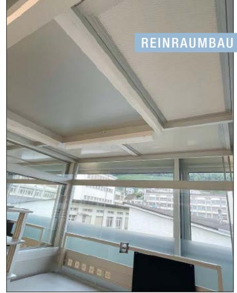
In die Zellendecken sind vier Filter Fan Units integriert. Da die Luft innerhalb der Zellen von der Decke bis zum Boden in einer laminaren Strömung geführt wird, können Partikelablagerungen auf den Werkstücken und Arbeitsoberflächen verhindert werden.
