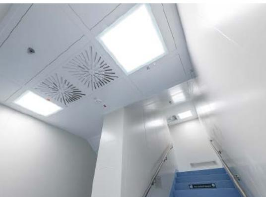
**Abb. 5: Reinraum-Treppenhaus mit Deckendetails wie Luftauslässen, Sprinklerköpfen und Sensoren**
