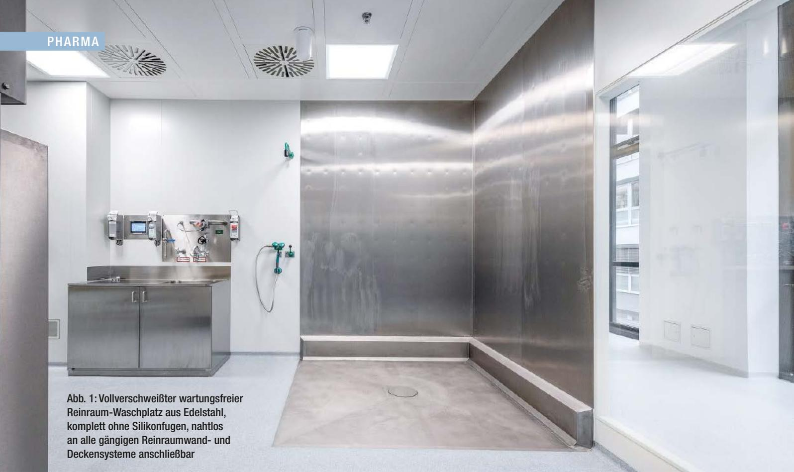
**Abb. 1: Vollverschweißter wartungsfreier Reinraum-Waschplatz aus Edelstahl, komplett ohne Silikonfugen, nahtlos an alle gängigen Reinraumwand- und Deckensysteme anschließbar**
