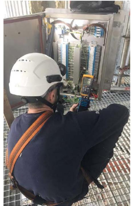
Finale Funktionsprüfung Schaltkasten
