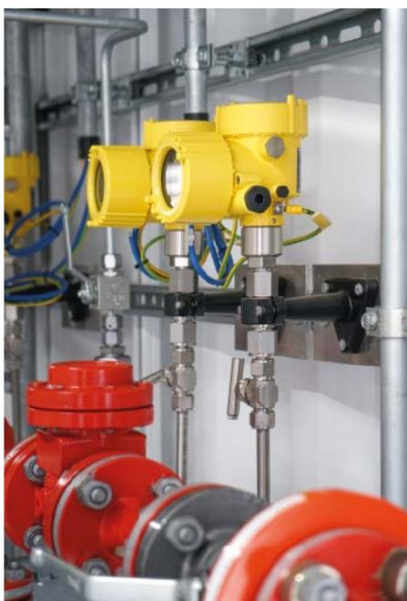
Die Druckwerte werden vor Ort angezeigt, aber auch an das übergeordnete Leitsystem übertragen.
