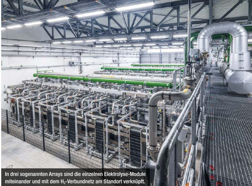
In drei sogenannten Arrays sind die einzelnen Elektrolyse-Module miteinander und mit dem H<sub>2</sub>-Verbundnetz am Standort verknüpft.
