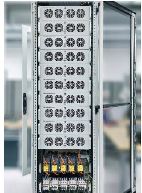
**Standardisierter 19-Zoll-Schaltschrank zur Versorgung eines Elektrolysemoduls**
