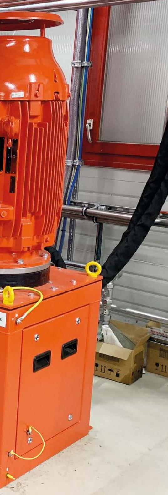
Abb. 1: Für den Maschinenraum in der Ex-Zone realisierte Bosch Rexroth die Kompaktaggregate in ATEX-Ausführung.
