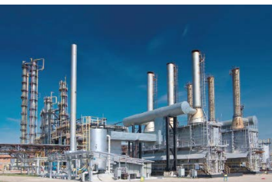
Anlagenverfügbarkeit mit Ethernet APL sicherstellen
