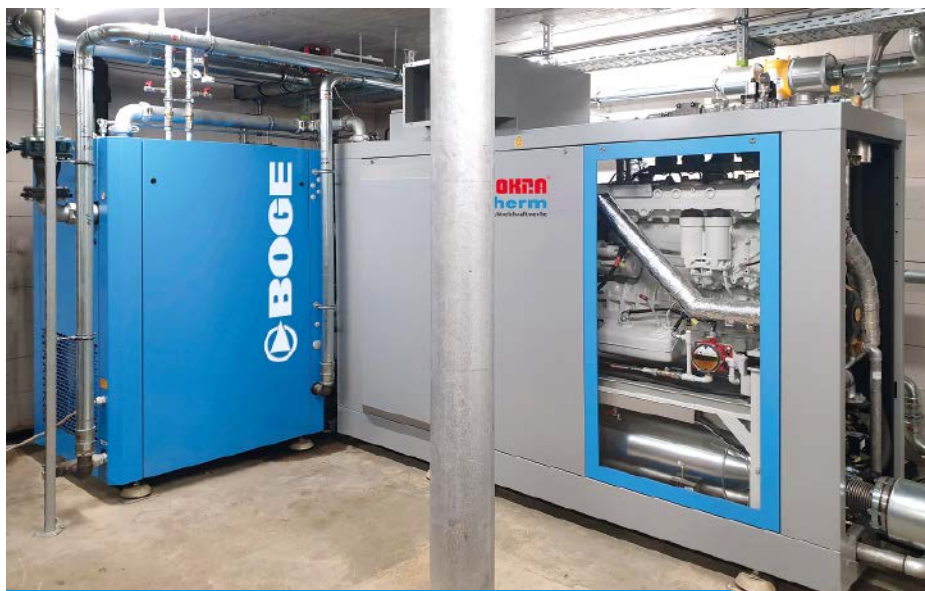
Das neue Gasmotor-Kompressormodul wird am besten zur Abdeckung der Grundlast eingesetzt und liefert einen thermischen Wirkungsgrad von fast 90 %.
