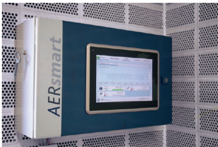
Abb. 3: Die -Verbundsteuerung AERsmart verteilt die geforderten Volumenströme so auf den Maschinenpark, dass Schwach-, Mittel- und Starklasten möglichst effizient abgearbeitet werden.
